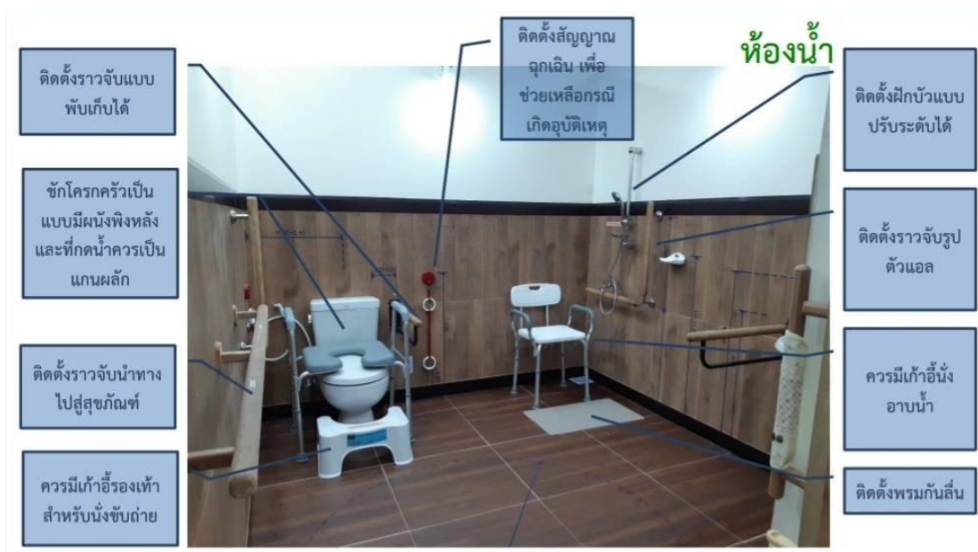
ภาพที่ 8 แสดงรูปห้องน้ำที่ติดตั้งอุปกรณ์สำหรับผู้สูงอายุ
